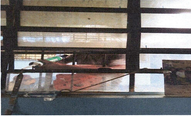
Foto 1: colocación de ventanas
