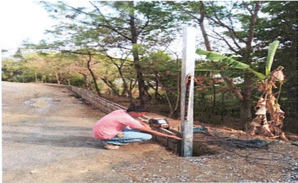
Foto 3: construcción muro perimetral
