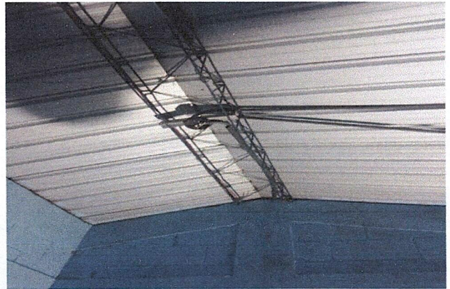
Foto 4: reparación del sistema eléctrico
