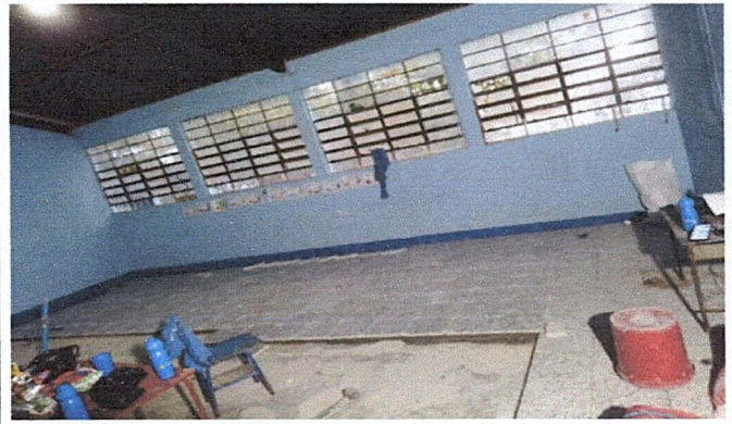
Foto 2: colocación de piso aula preprimaria
